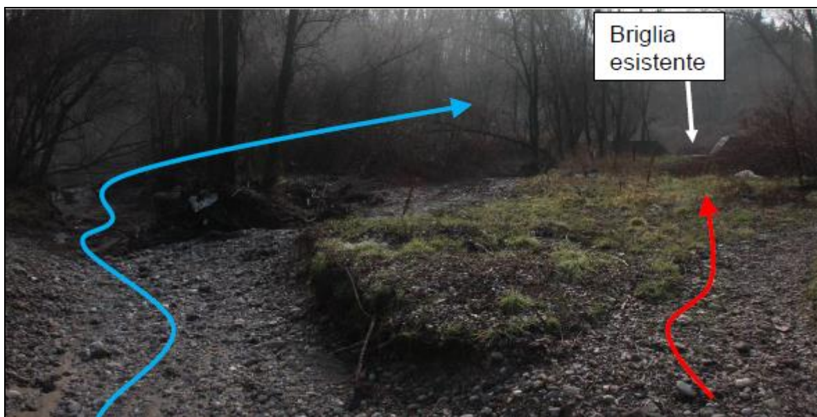
Figura 21: situazione inerente la briglia aggirata-vista da monte verso valle. Freccia Rossa=antico corso del rio; freccia Blu=corso del Rio attuale, accompagnato da una maggiore erosione dell'alveo.
